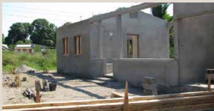
2013. Costruzione della prima Casa Ninna Mamma a Chissano
