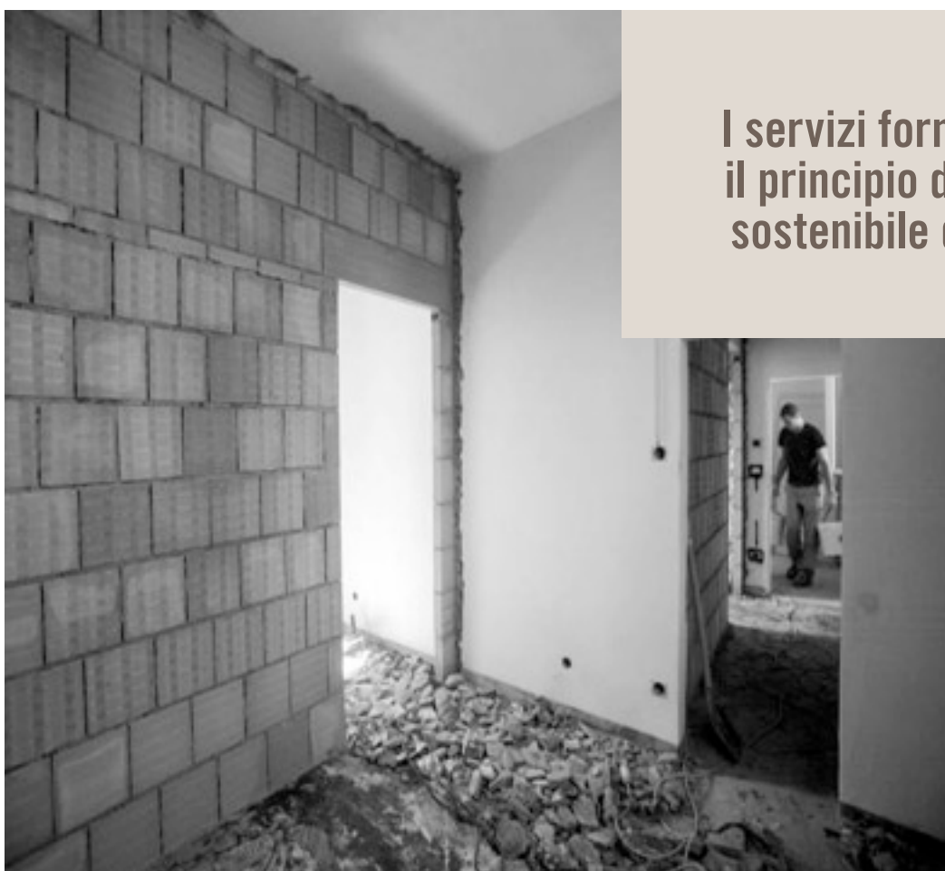
2011. Una fase della ristrutturazione del Centro San Ruffillo
